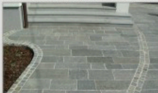
Hauszugang aus grau-grünem Luserna-Gneis , große Produktverfah an Bahnen, Würfel, Stufenplatten
